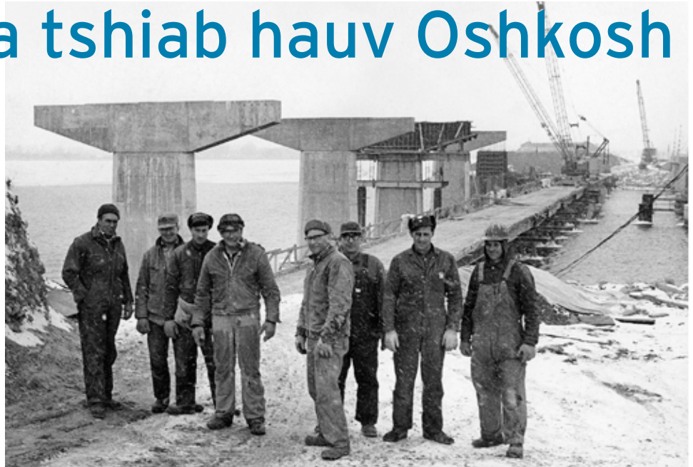
Thawj tus choj hla hauv dej hia txwv Lake Butte des Morts tau tsim ua xyoo 1955. Hauv daim duab no, cov neeg ua haujlwm ceebtoom ua ntej txog cov khaux khaum siv zuab puam ua raug tsim ua rau xyoo 1968 thiab 1969.
