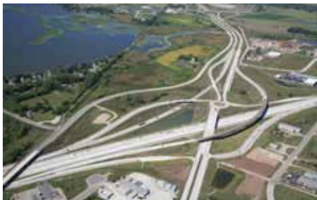
Vista aérea de la intersección con US 45 tomada en septiembre de 2012.
