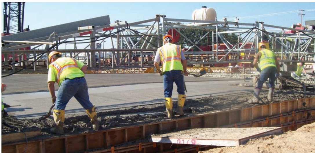
Obreros realizan trabajos estructurales en la calle Koeller en Oshkosh
